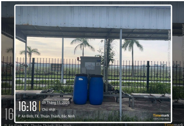
Cụm châm hóa chất và tủ điều khiển ngoài trời
