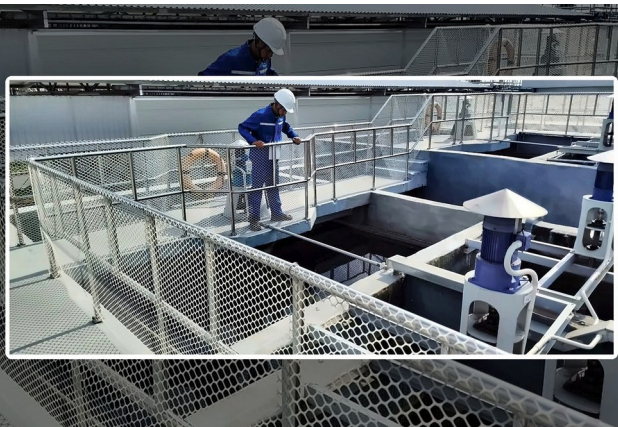
Kiểm tra hiện trạng bể và thiết bị khuấy
