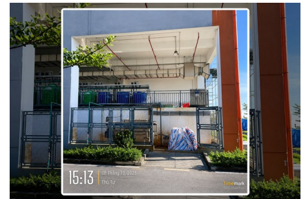
Cụm bồn hóa chất và hệ thống châm định lượng
