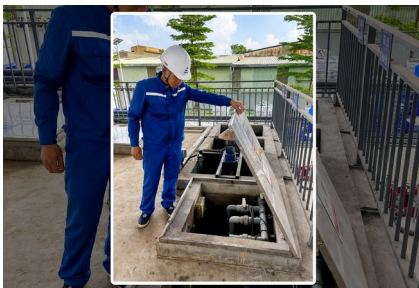
Kiểm tra thiết bị khuấy và đường ống công nghệ
