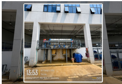
Máy ép bùn khung bản tại khu xử lý bùn
