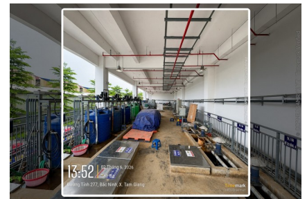
Bố trí bồn hóa chất, bơm định lượng và hố công nghệ
